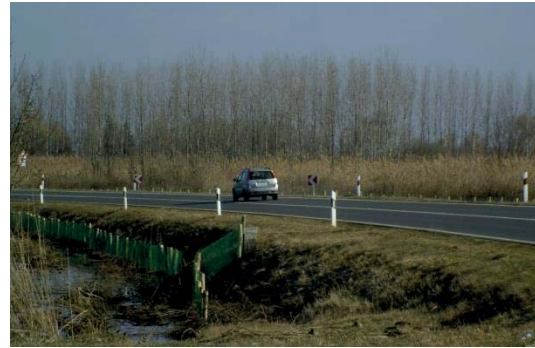
4. ábra: Terelőkerítés elvégződésének rossz kialakítása a 33. sz. főút hortobágyi szakaszán (fotó: Mester Béla)
