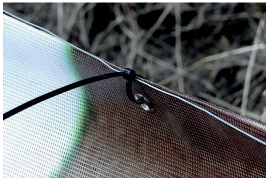
9. ábra: Erősített tartólyukkal ellátott molinó vastag vezérdróthoz rögzítése gyorskötözővel (fotó: Mester Béla)
