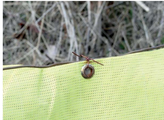
8. ábra: Erősített tartólyukkal ellátott molinó vastag vezérdróthoz rögzítése rézdróttal (fotó: Mester Béla)
