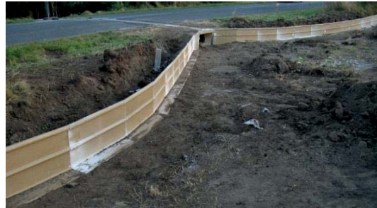
2. ábra: ACO kétéltűvédelmi terelőrendszer Hontnál, a 2. sz. út mentén (fotó: Kéri András)
