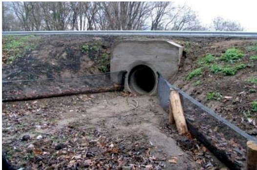
3. ábra: Kerítés és ökológiai átjáró a 2. számú főútnál Parassapuszta előtt (fotó: Kéri András)
