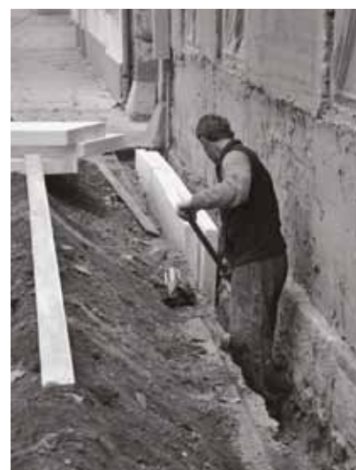
Az alap melletti utólagos hőszigetelés kivitelezése, Vác
